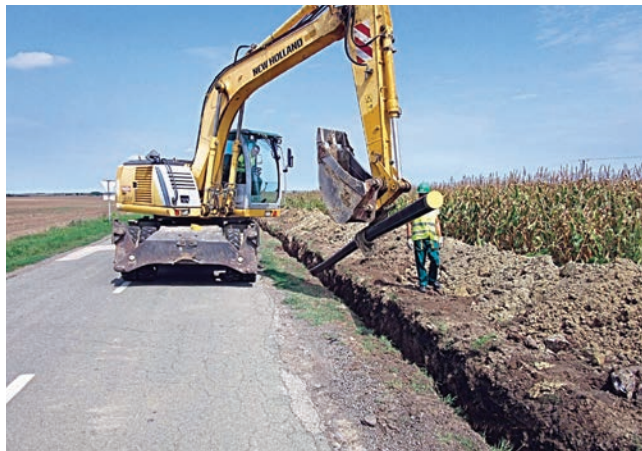
Polaganje vodoopskrbnih cjevovoda u Veri
