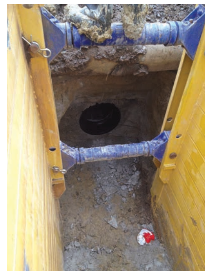
Iskopi za kanalizaciju u Voćinskoj ulici u Borovu naselju
