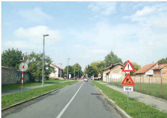
Detalj radova sanacije i gradnje kanalizacijskog sustava u Vukovaru
