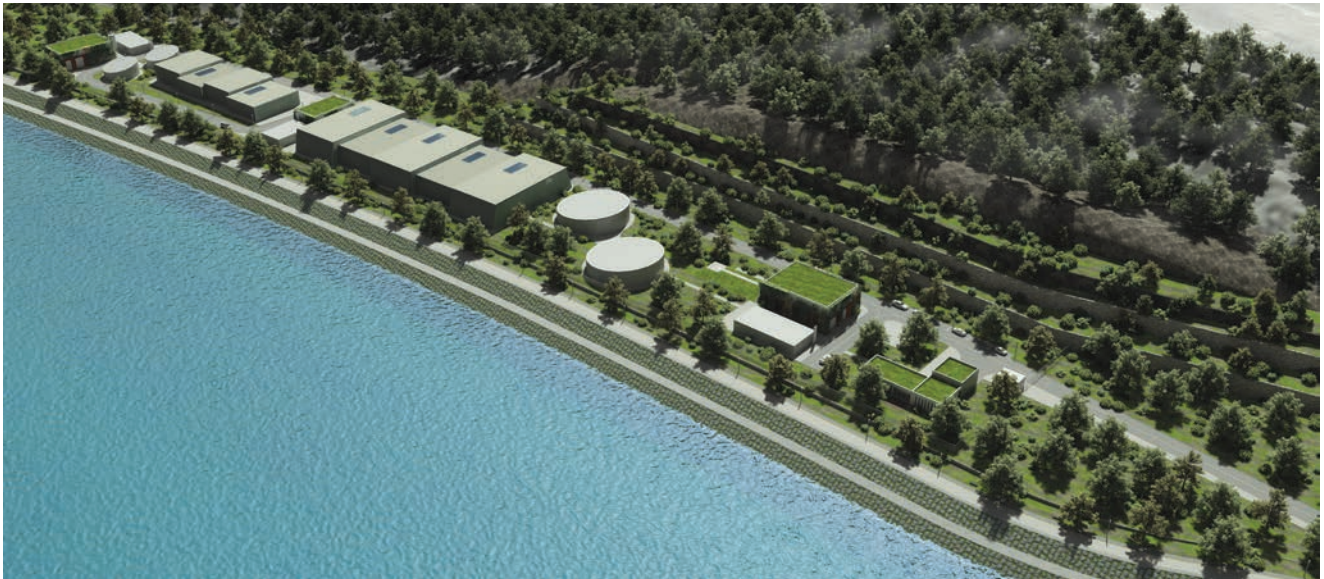
Pogled iz zraka na budući uređaj za pročišćavanje otpadnih voda u Vukovaru
