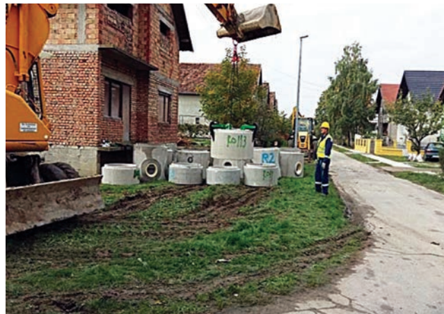
Iskrčavanje dijelova betonskih okana u Lipovači
