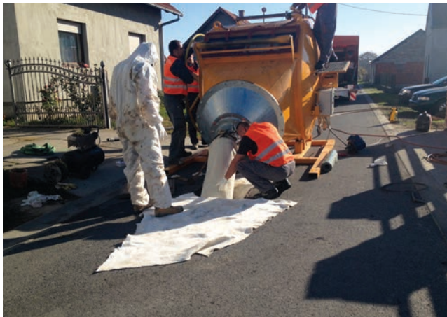
Rekonstrukcija kanalizacijskog sustava bez raskopavanja
