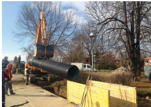
Polaganje cijevi za novi dio kanalizacijskog sustava
