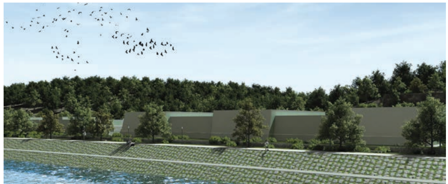
Budući uređaj za pročišćavanje otpadnih voda (pogled s Dunava)
