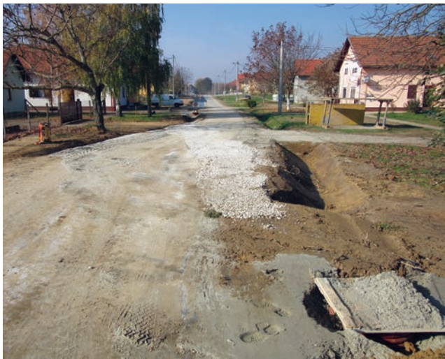
Dio Bogdanovaca gdje su radovi gradnje kanalizacije pred završetkom
