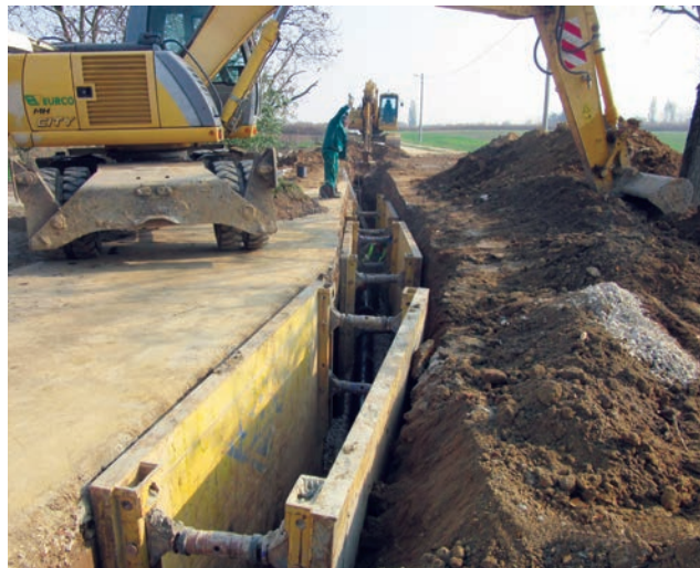
Kopanje kanala za kanalizacijsku cijev u Bogdanovcima
