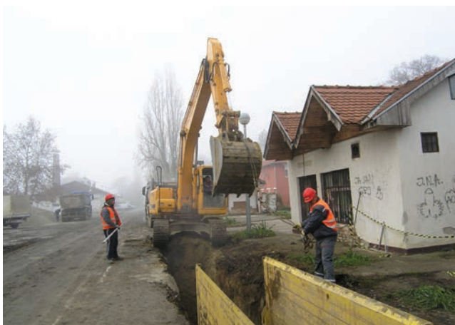
Iskop kanala u Ulici Vila Velebita
