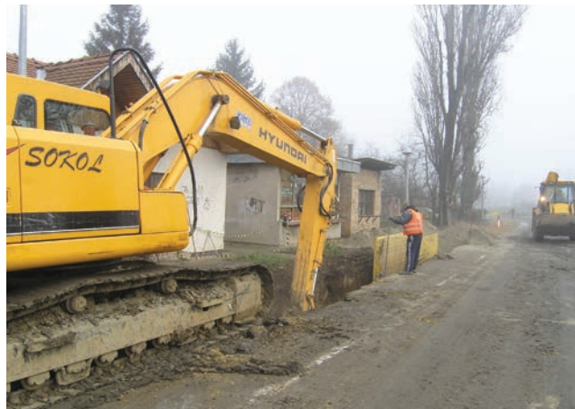
Gradnja novog kolektora u Ulici Vila Velebita u Borovu naselju
