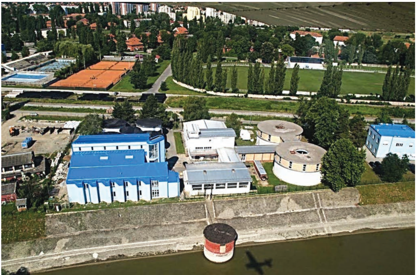
Pogled iz zraka na vodoopskrbna postrojenja s vodozahvatom u Borovu naselju
