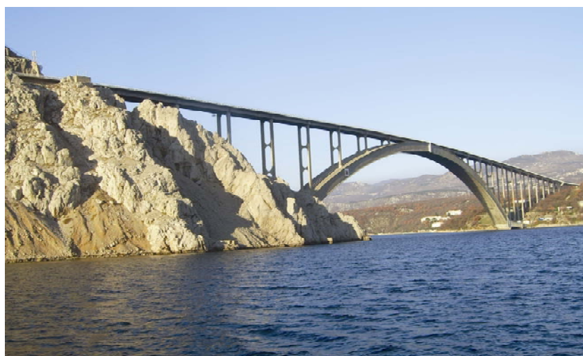
Veći luk Krčkog mosta –jedan od najvećih armiranobetonskih lukova na svijetu
