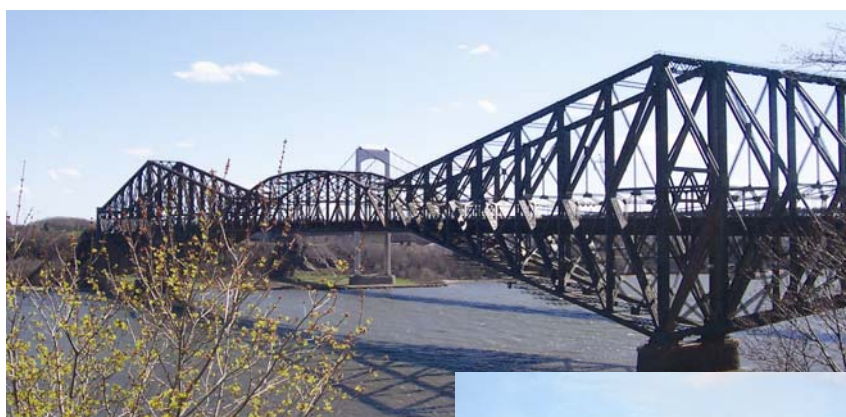
Pont de Quebec – najduži konzolni most na svijetu
