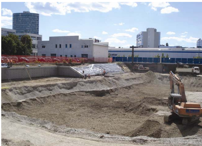
Zemljani radovi na građevnoj čestici
