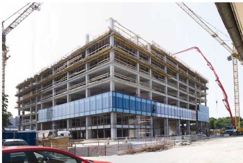
Betonski radovi i početak ostaklivanja pročelja (snimio: K. Šibalić)
