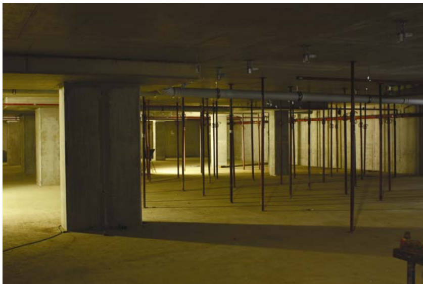
Garažni prostori tijekom izgradnje (snimio: K. Šibalić)
