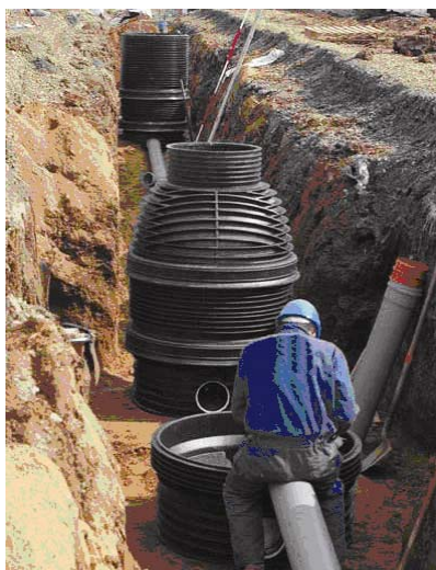
Postavljanje revizijskih okana
