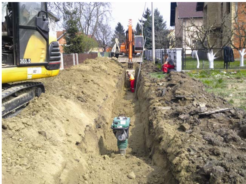
Iskop rova za kanalizacijski cjevovod u Bilju
