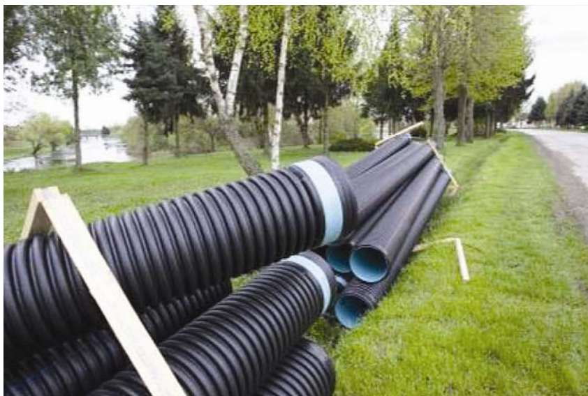
Pripremljene cijevi za kanalizaciju Cerne
