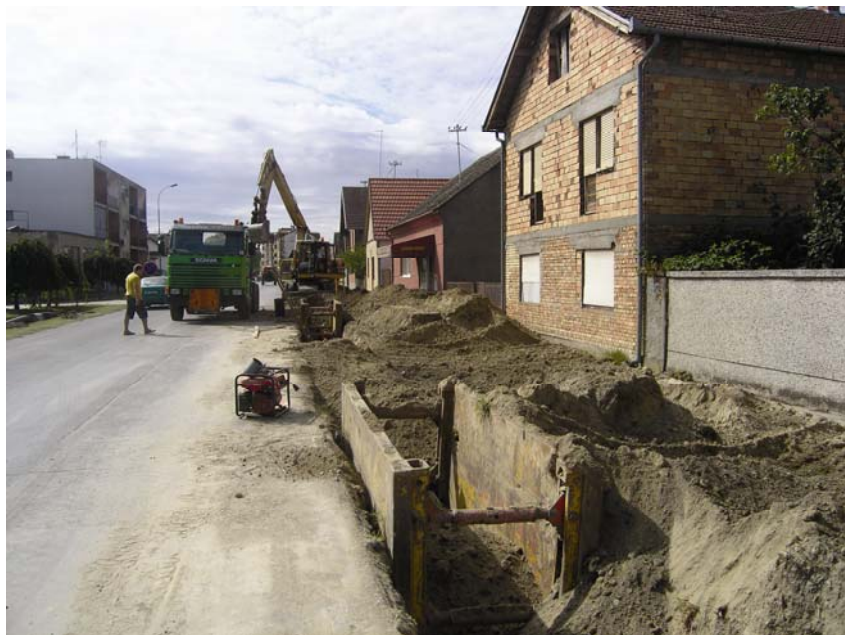
Gradnja kanalizacije u glavnoj ulici u Dardi
