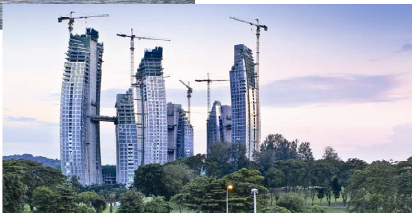
Tornjevi u završnoj fazi gradnje
