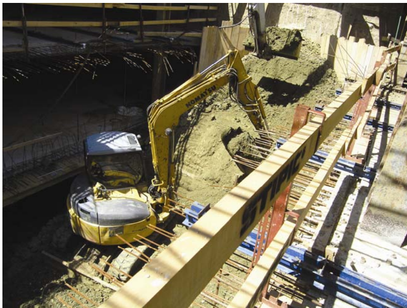
Iskop zemlje ispod stropne ploče
