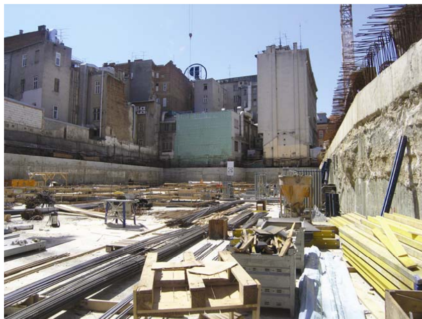
Pogled na gradilište s istoka
