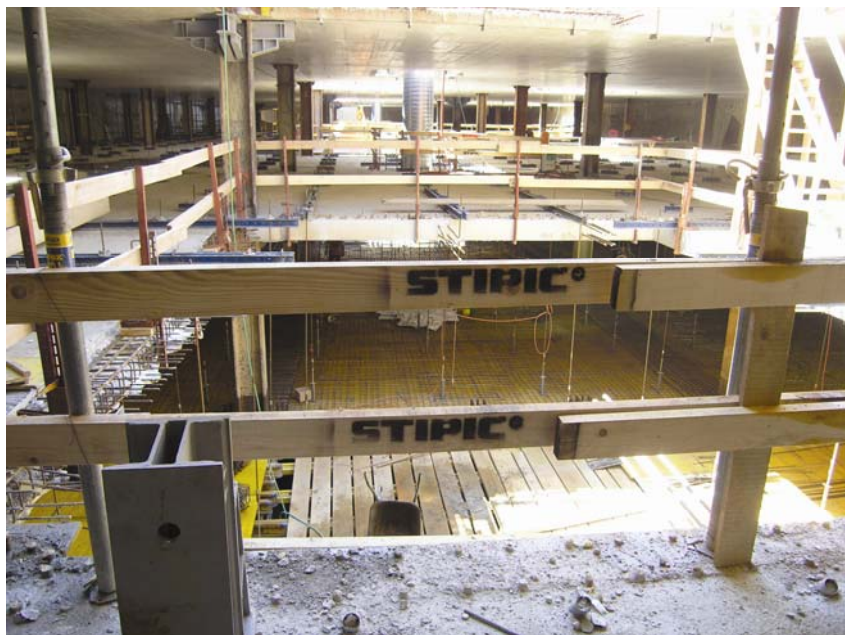
Podzemne armiranobetonske ploče na više razina
