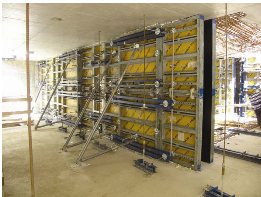
Oplata pregradnog zida izvedenog SCC betonom
