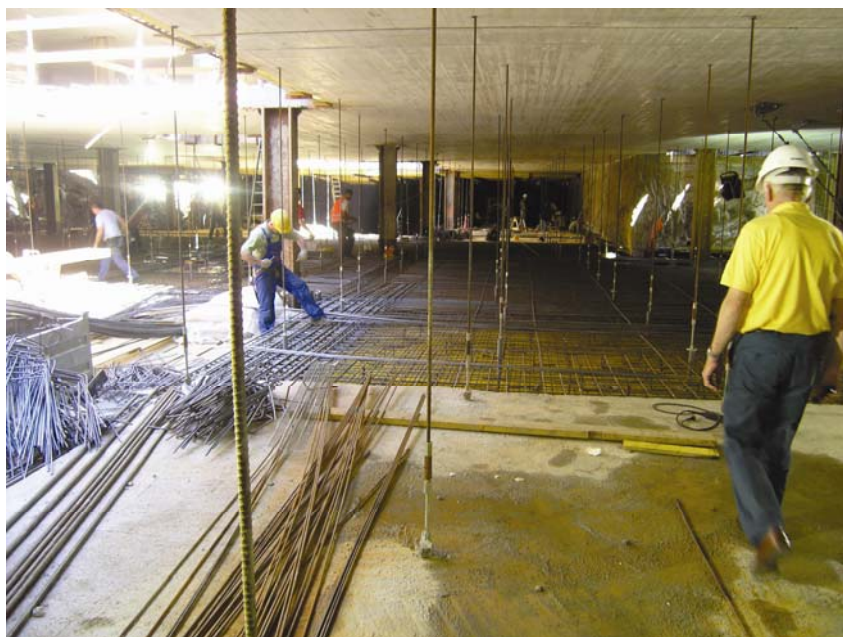
Armiranje i priprema za betoniranje nove sekcije
