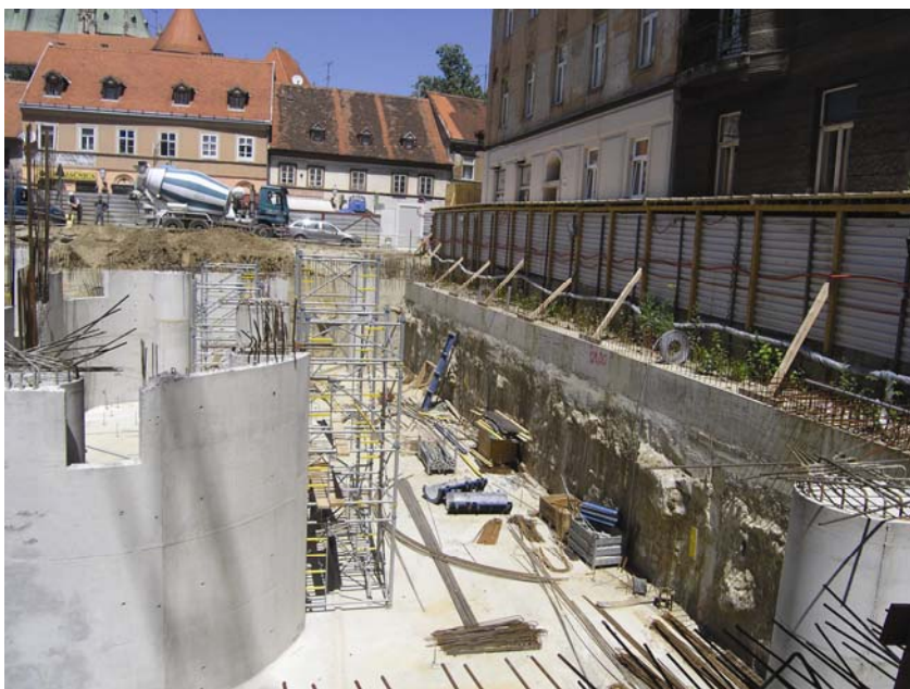
Dio gradilišta uz Kurelčevu ulicu
