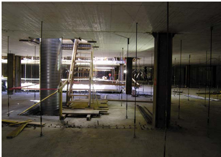
Čelični stupovi, vješaljke oplatnih stolova i ventilacijska cijev
