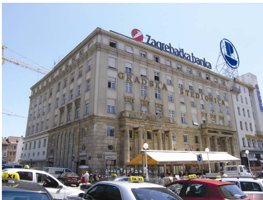
Zgrada Gradske štedionice na uglu Jelačićeva trga i Cesarčeve ulice
