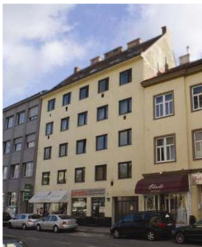
Slika 3. Pročelje zgrade u kojoj je obnovljen stan
