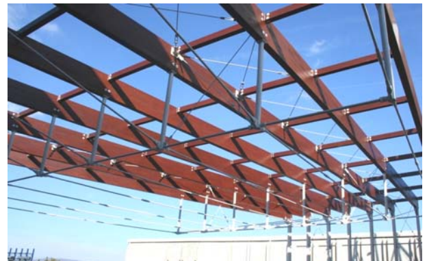
Slika 9. Prikaz izvedene konstrukcije
