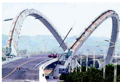
Pogled na gradilište nakon izvedbe lučnih rebara
