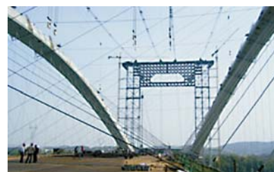
Pogled na sustav u gradnji
