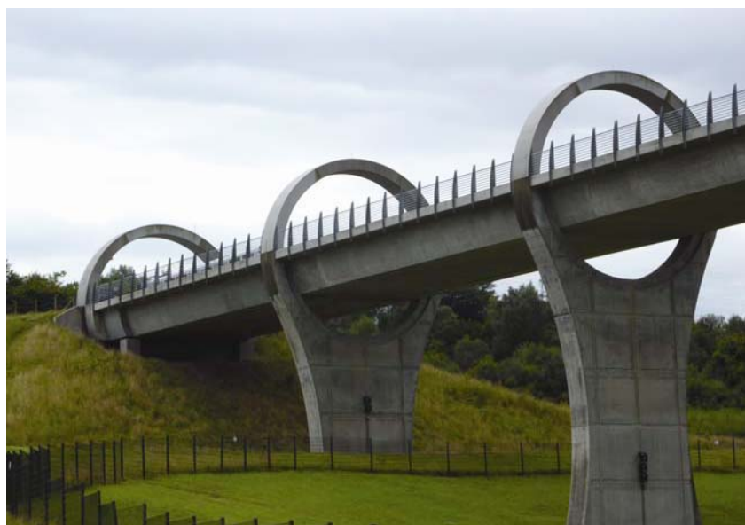
Pogled na dio novosagrađenog akvedukta
