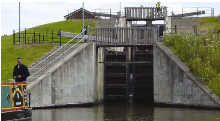
Pogled na ustave na kanalu Forth i Clyde
