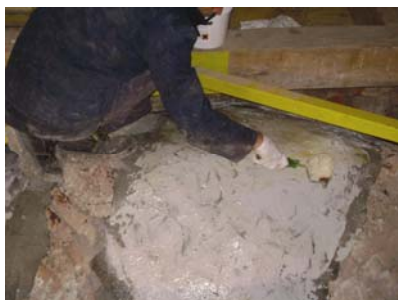
Nanošenje reparaturnog morta
