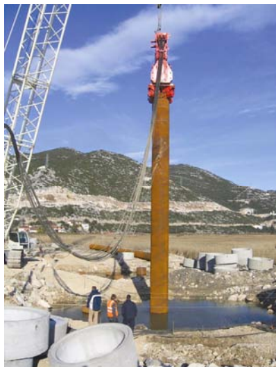
Pobijanje čeličnog pilota
