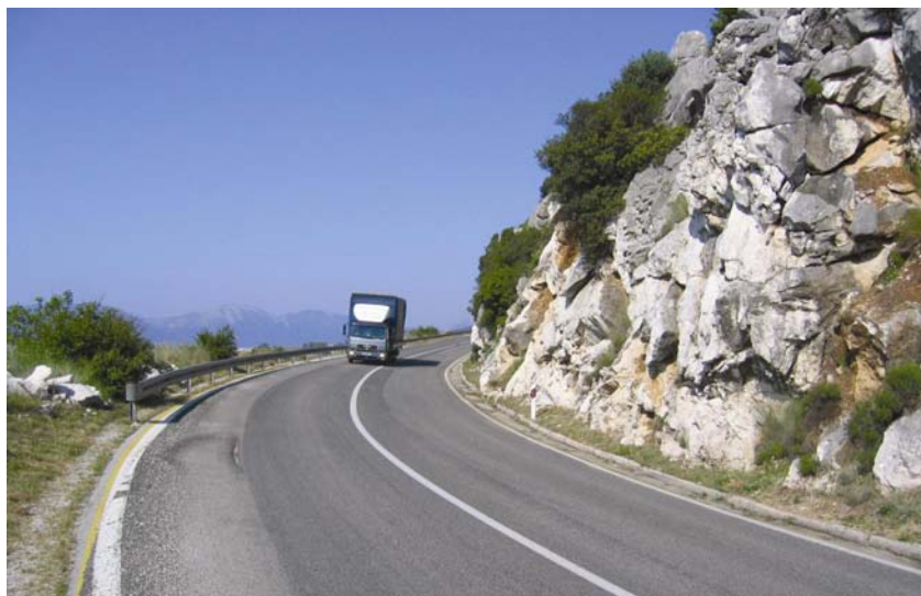
Mjesto gdje je predviđeno usijecanje ceste D8 u brijeg
