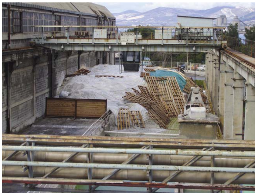
Dio tvornice u krugu negdašnje tvornice Salonit u Vranjicu
