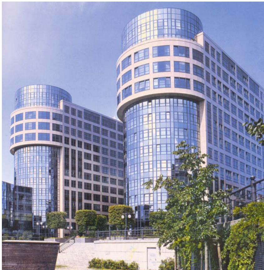
Zgrada Saveznog ministarstva unutrašnjih poslova
