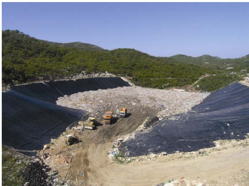
Dovoženje novog otpada na sanirano odlagalište Grabovica
