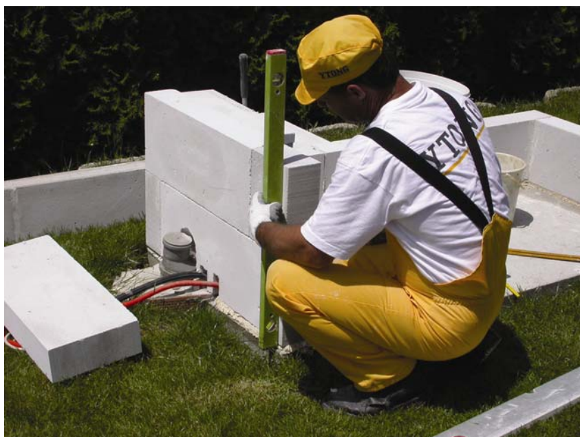
Početak izgradnje kamina
