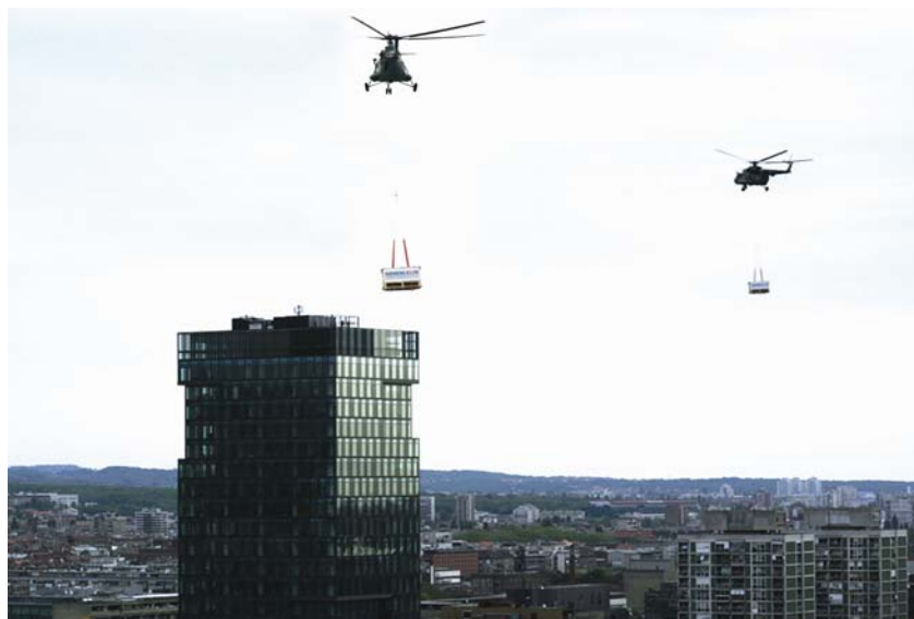
Prijenos agregata helikopterom na vrh Eurotowera
