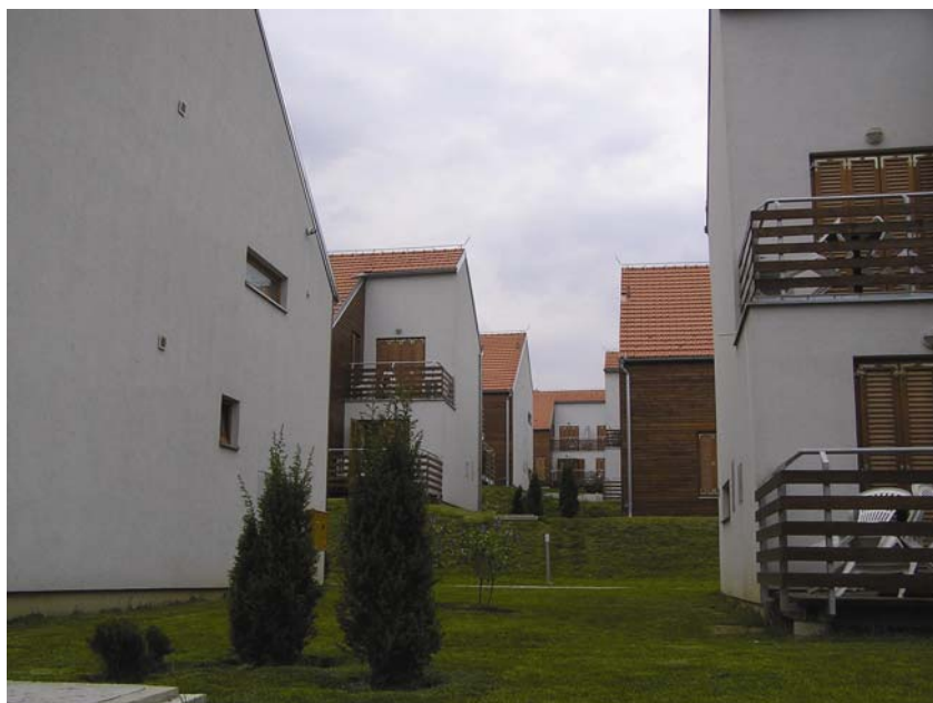
Pogled na apartmansko naselje
