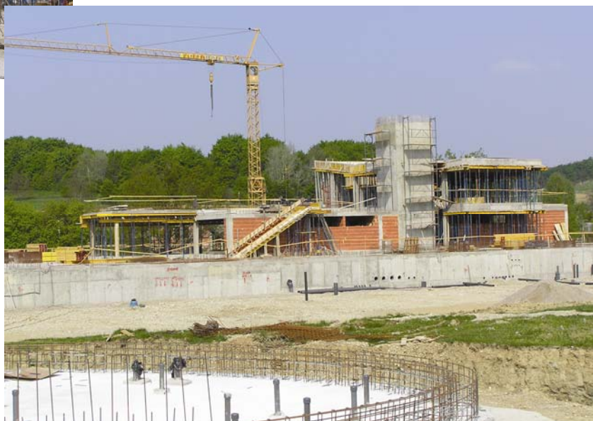
Pogled na gradilište restorana i otvorenoga bazena
