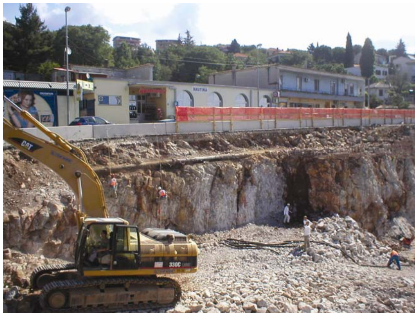
Iskop uz Istarsku ulicu za buduću garažu
