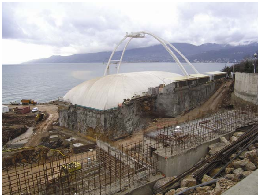
Postojeći bazen ispod balona okružen gradilištem
