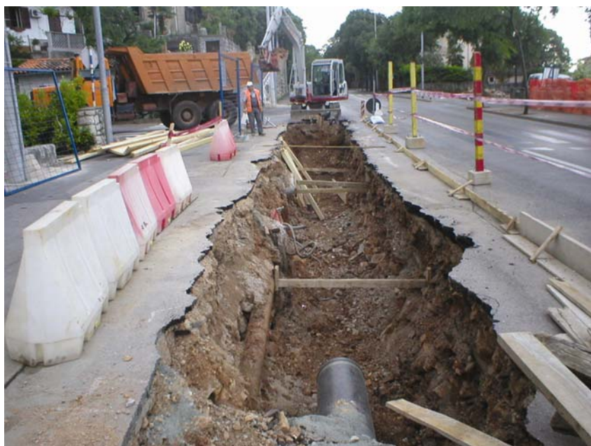
Prelaganje tlačnoga magistralnog vodovoda
