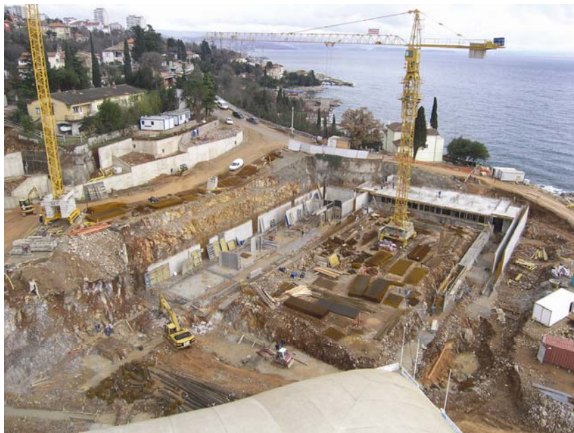
Pogled na istočni dio gradilišta
