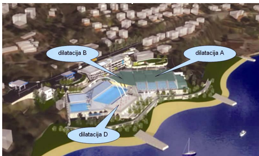
Građevine (dilatacije) novoga bazenskog kompleksa
