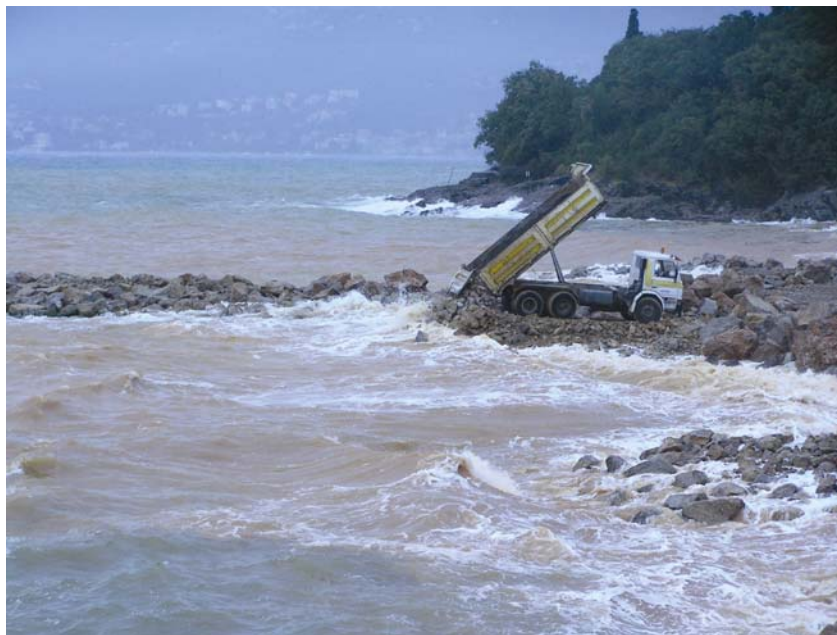
Nasipanje plažnog pojasa za nemirna mora
