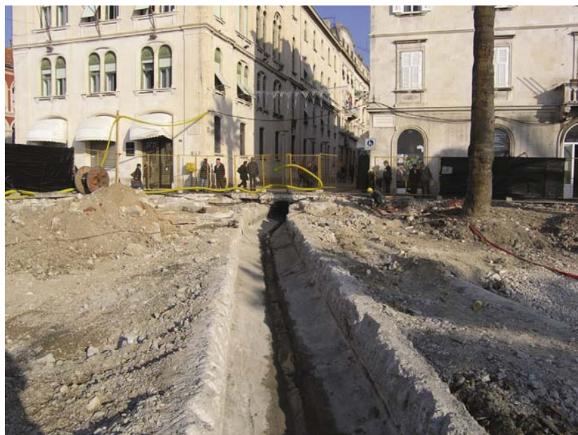
Uređivanje kanalizacije i sumpornog odvoda iz Marmontove ulice
