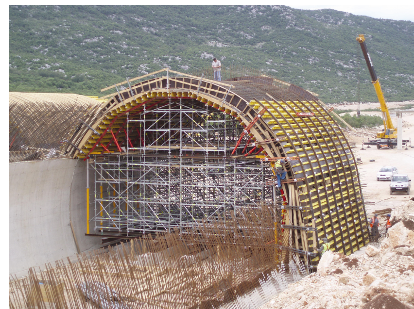
Vanjska i unutarnja oplata tunela
