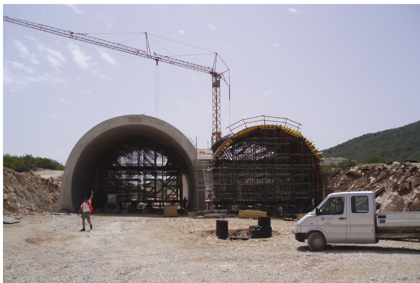
Pogled na tunel Rošca, jedna cijev betonirana, druga u izgradnji
