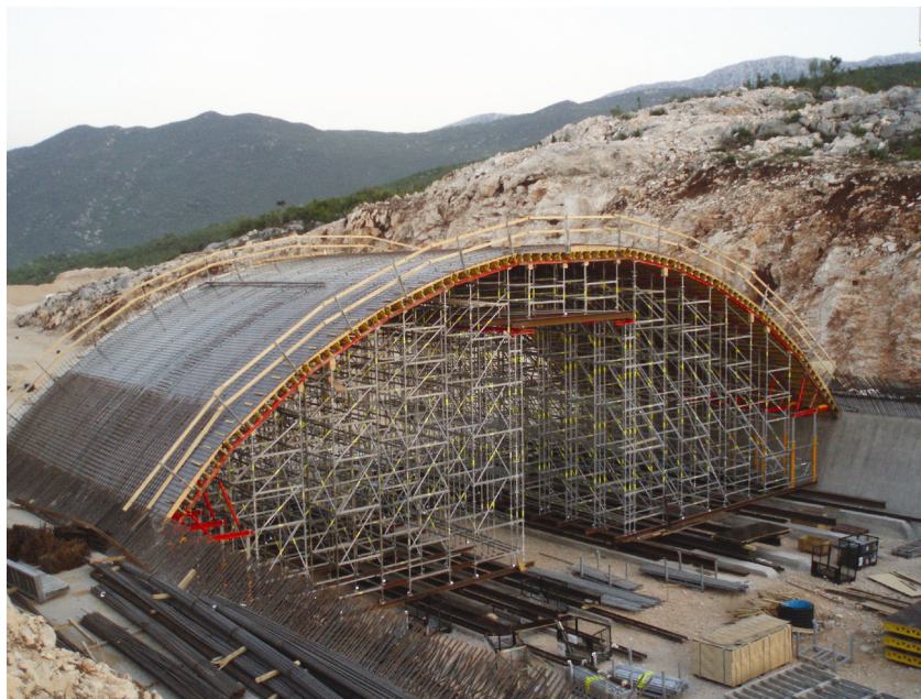
Tunel Konščica u oplati tijekom izvedbe
