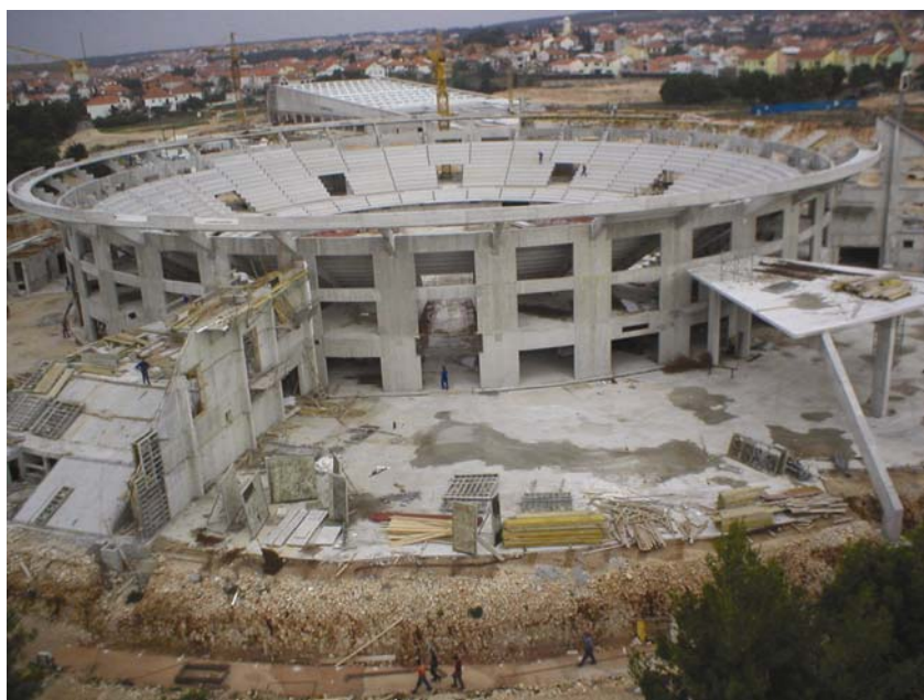
Dvorana s dovršenim armiranobetonskim radovima
