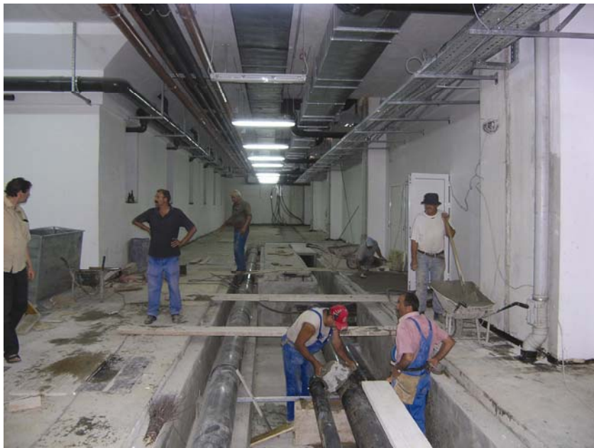
Montaža instalacija u prostoru ispod bazena
