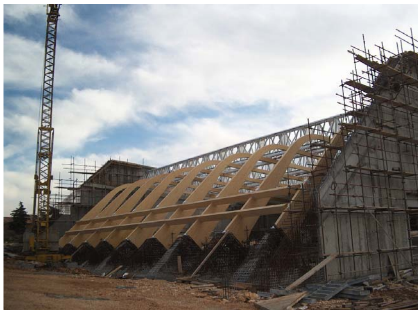
Ugradnja drvenih nosača krovišta bazena
