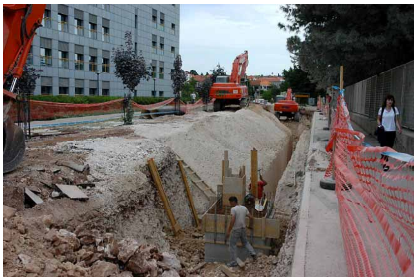
Ugradnja glavnih kolektorskih cijevi
