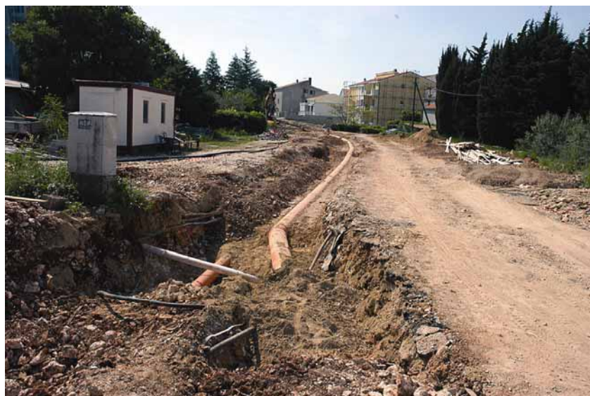
Gradnja kanalizacije na području Borika
