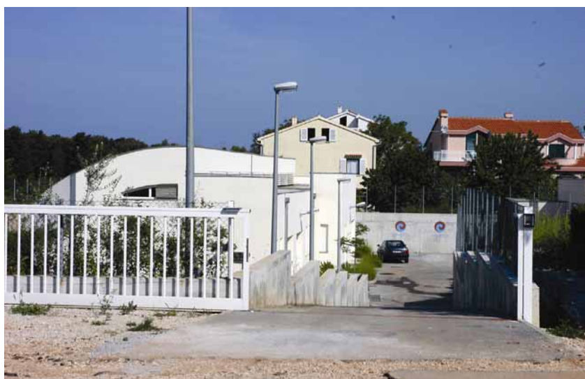
Zgrada uređaja za pročišćavanje Borik
