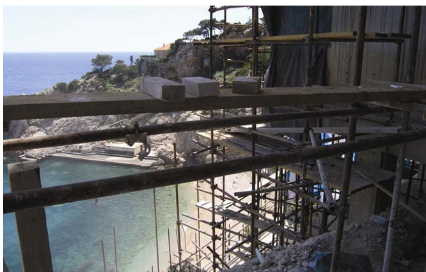
Radovi na sjevernoj strani (bivša Florida)
