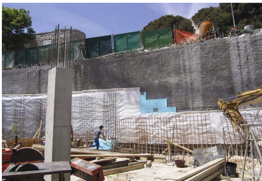
Gradilište uz ulični zid
