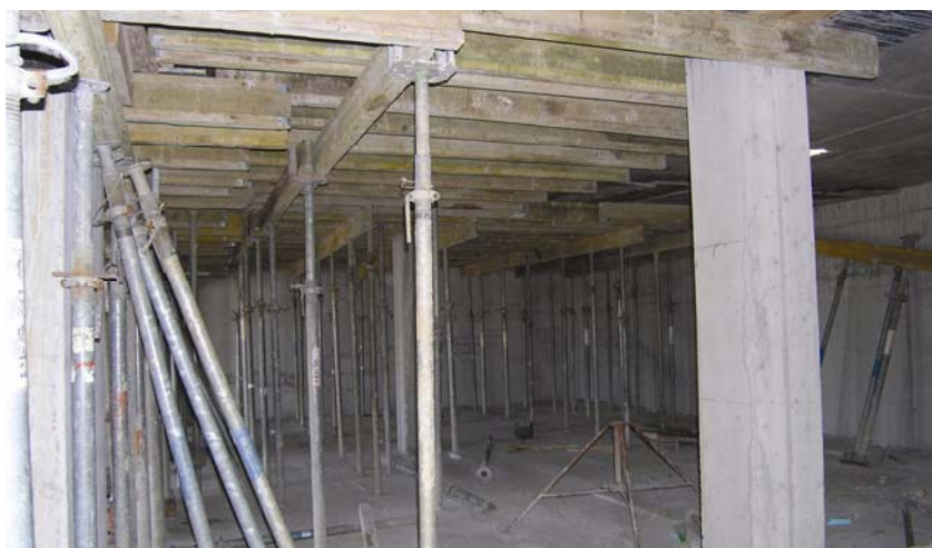
Unutrašnjost polivalentne dvorane u gradnji
