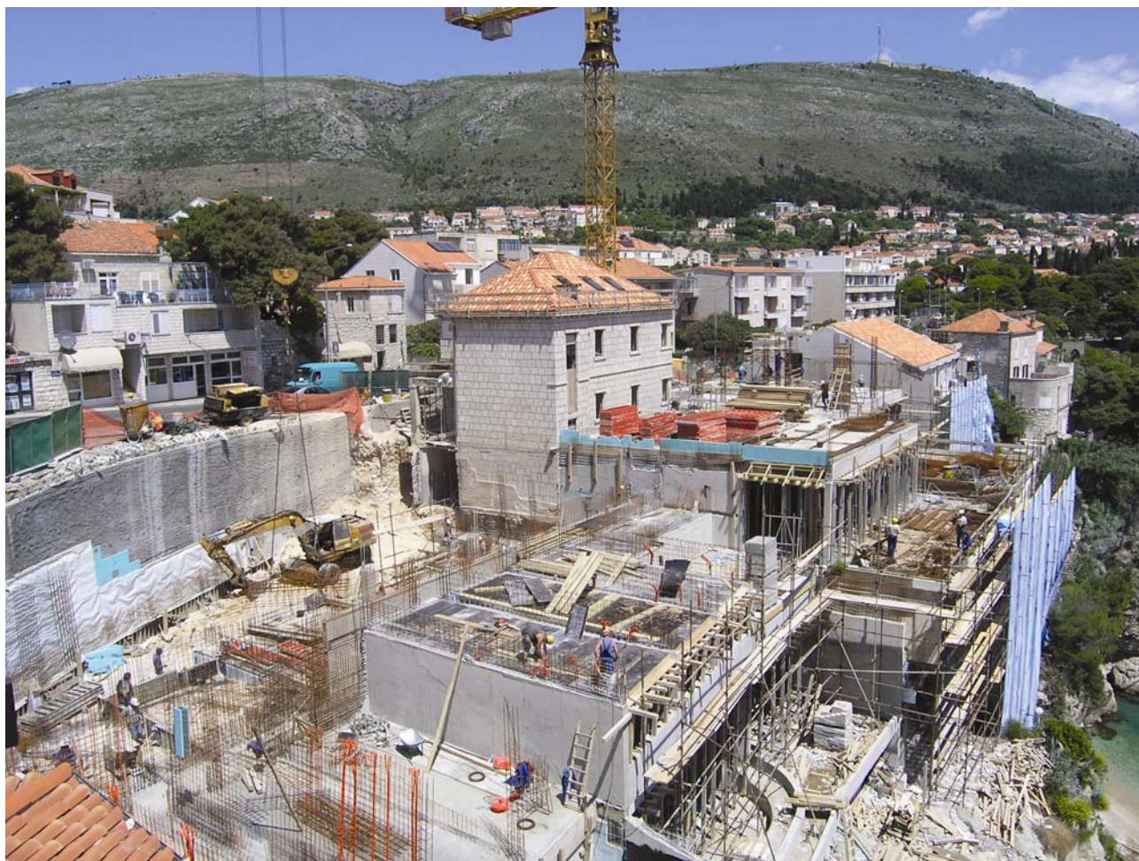
Pogled na gradilište
