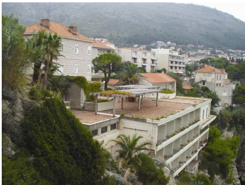
Hotel uoči početka obnove
