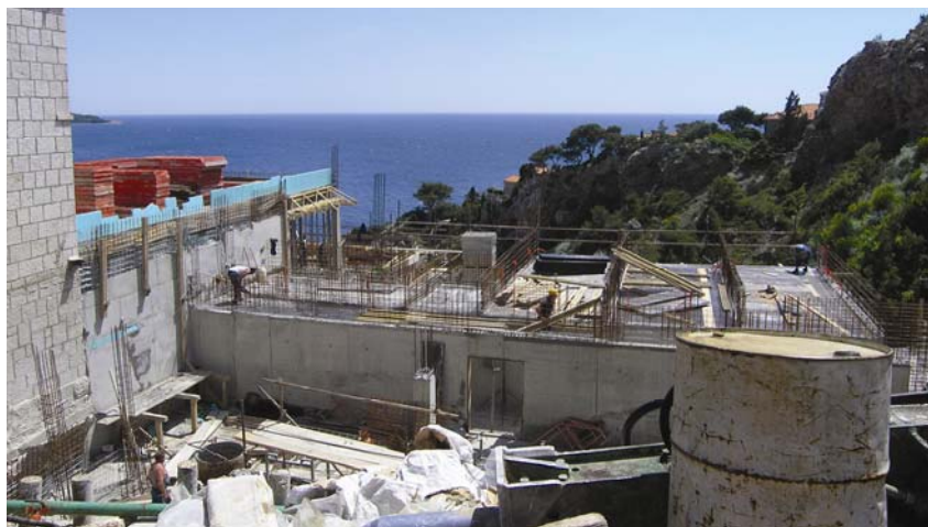
Južni dio gradilišta
