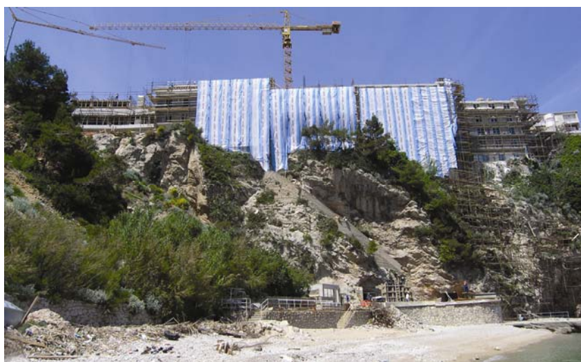
Pogled na gradilište s morske razine
