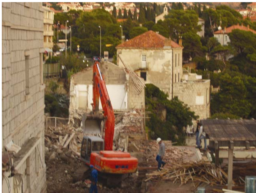
Djelomična razgradnja prije rekonstrukcije
