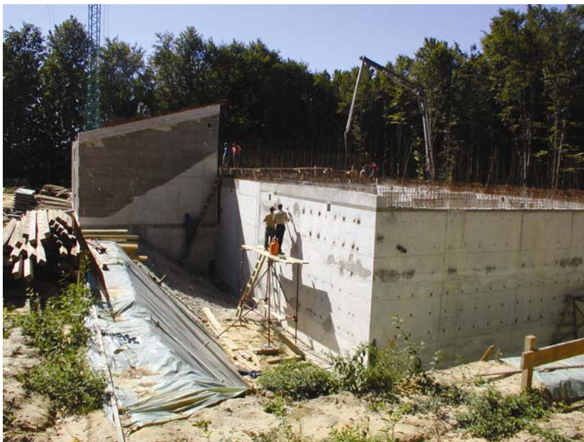
Vodospremnik Banov Stol u gradnji
