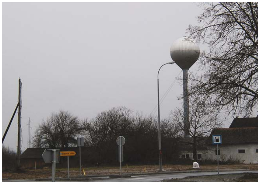
Vodotoranj u Velikim Zdencima
