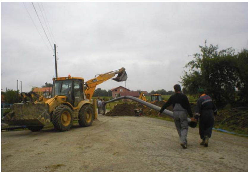
Radovi na polaganju cjevovoda
