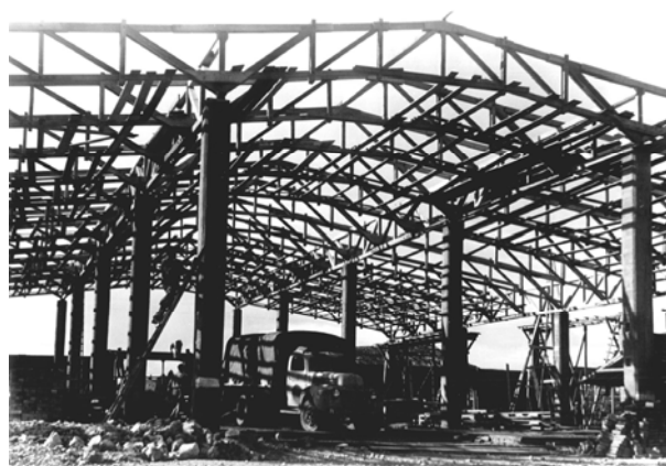
Montažna konstrukcija lučkog skladišta u Gružu
