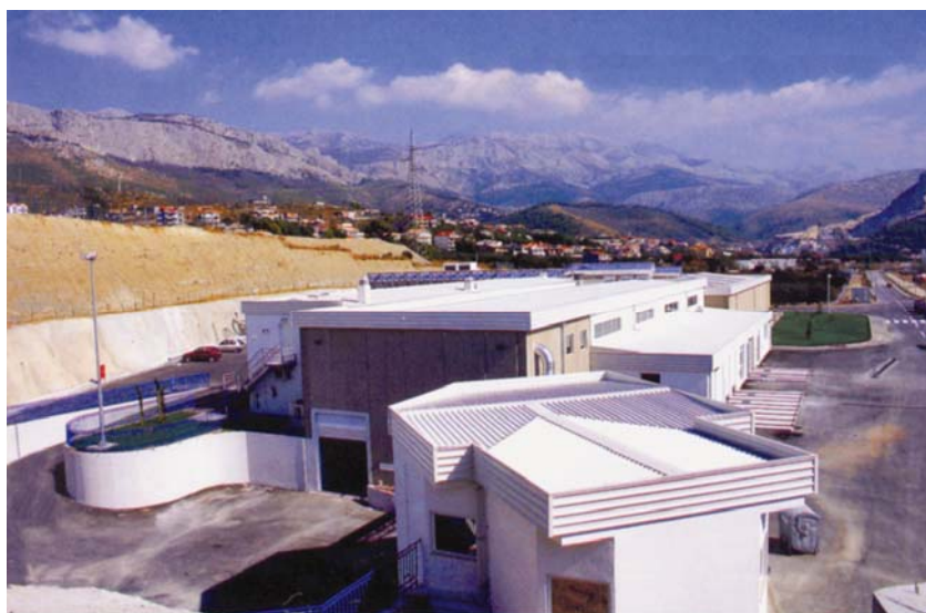
Uredaj za pročišćavanje Stupe
