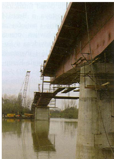
Gradilište mosta snimljeno s desne obale Save
