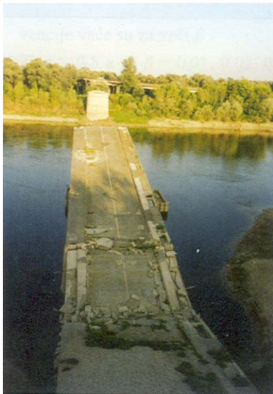
Srušeni most snimljen s lijeve obale Save povezanih mostova završava prilaznim i u ratu manje oštećenim mostom, dugim 64 m (2 x 32 m), na desnoj obali Une u malom mjestu Gradina na bosanskoj strani.
