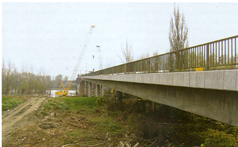
Prilazni dio mosta na lijevoj obali
