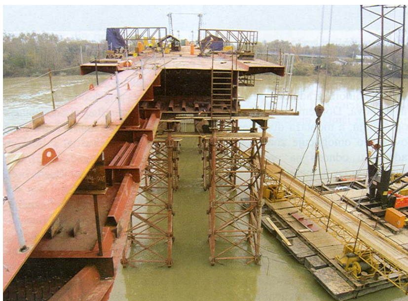
Montaža čeličnih nosača
