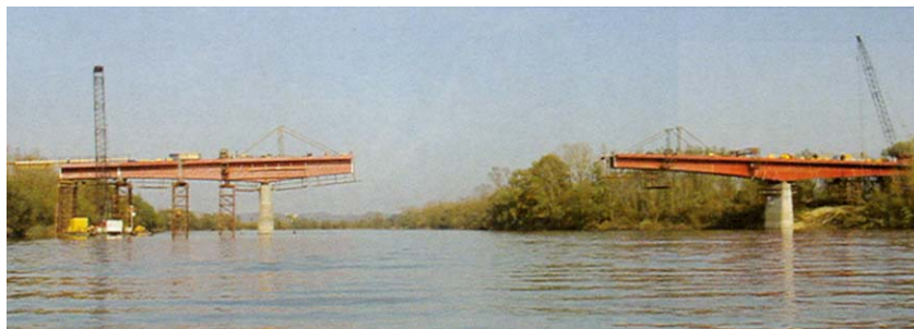
Pogled na gradilište s čamca na Savi
