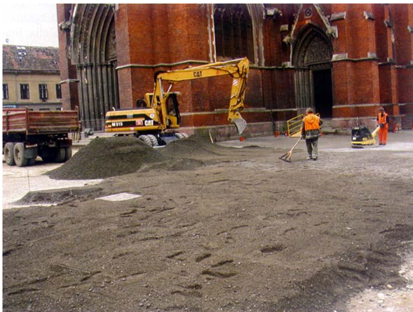
Ugradnja završnog sloja kolničke konstrukcije na Trgu Marina Držića
