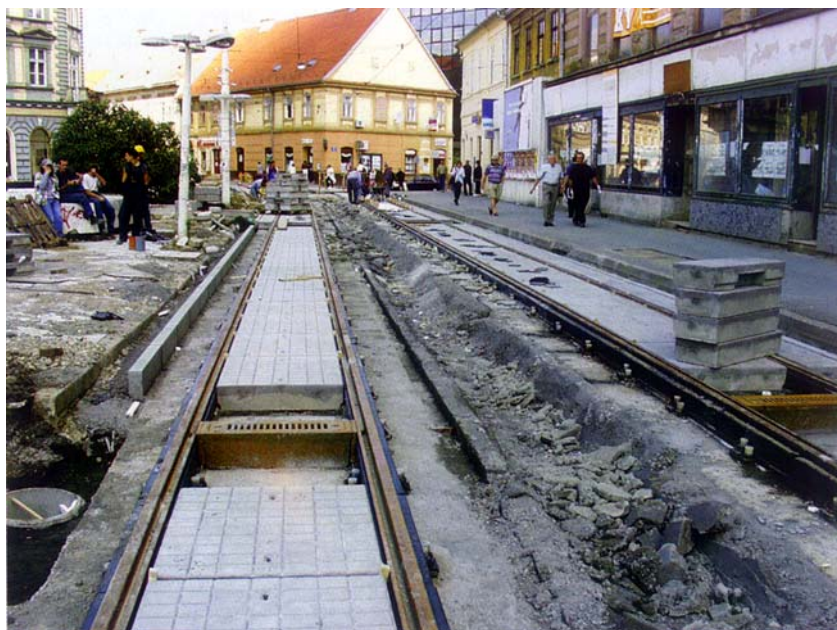
Ugradnja tramvajske pruge na Trgu Ante Starčevića
