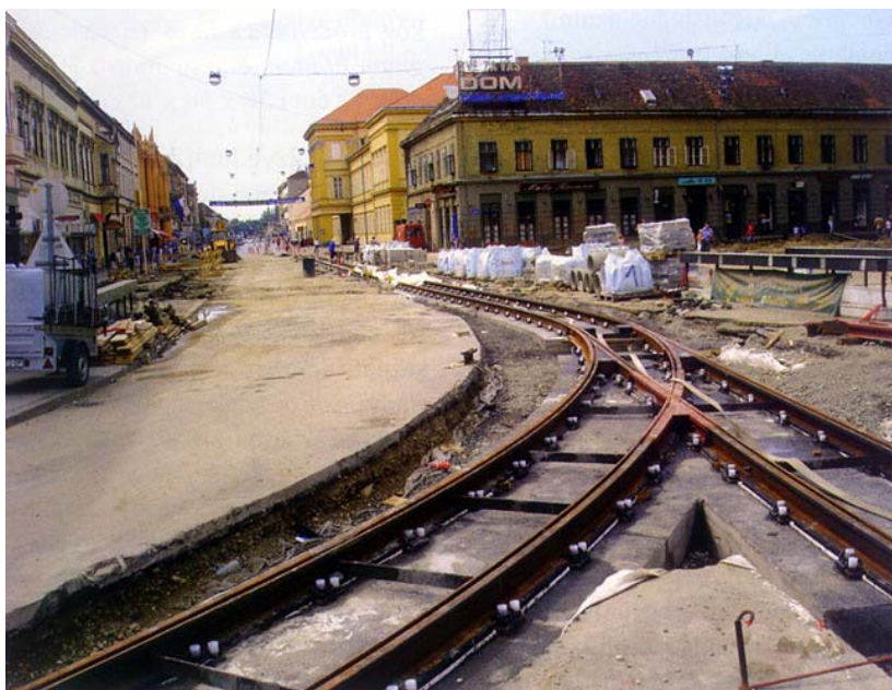
Nova tramvajska pruga na Trgu Marina Držića
