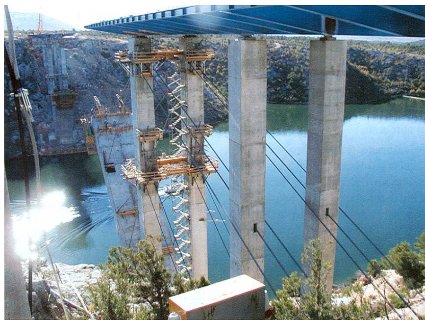
Pogled na gradilište sa skradinske strane
