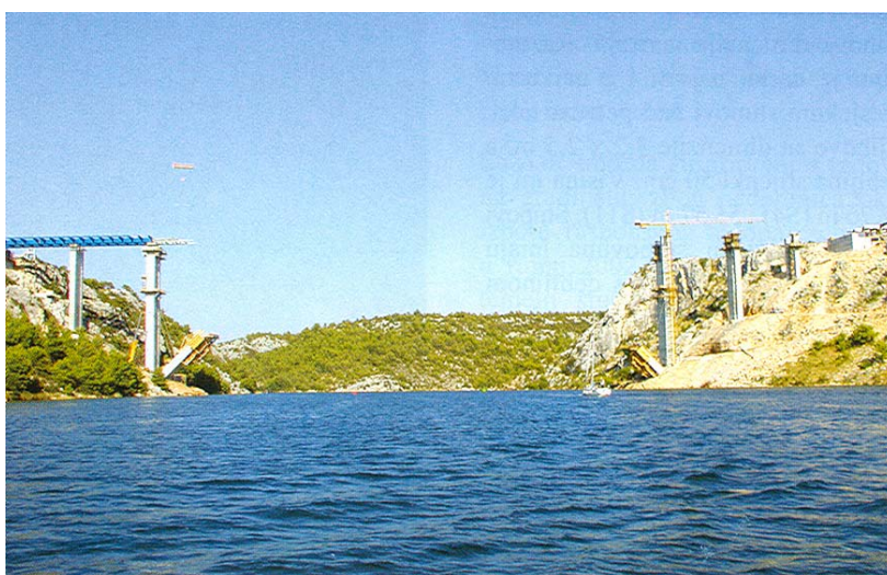
Pogled iz čamca na gradilište na početku gradnje lukova
