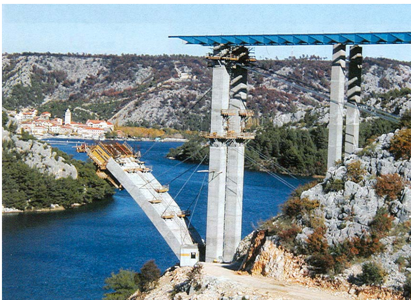
Gradilište luka i stupova na šibenskoj strani
