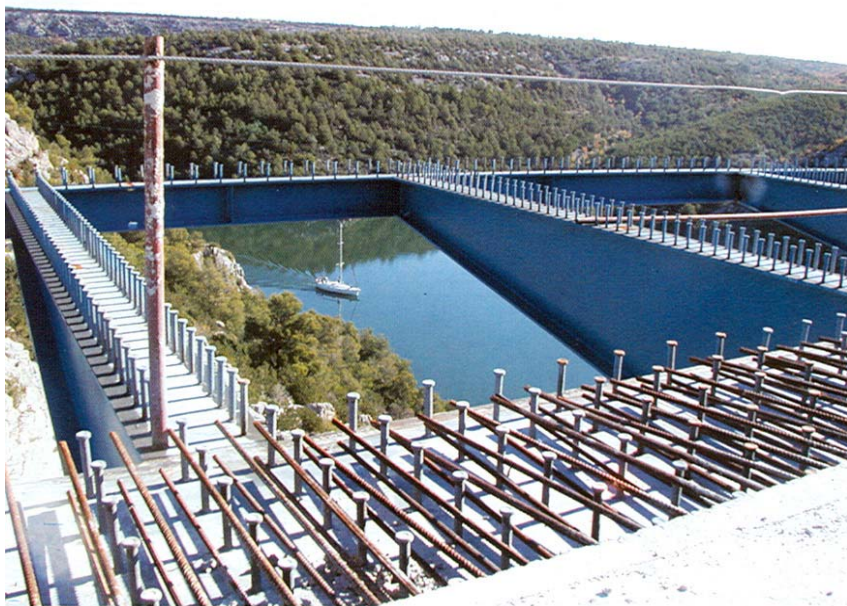
Rubovi čeličnih nosača s dijelom kolničke ploče
