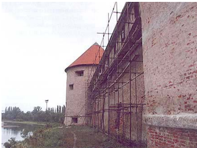
Dio utvrde uz Kupu sa skelama za obnovu
