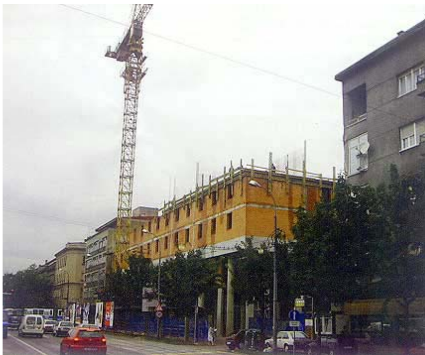
Pogled na izgradnju hotelskog dijela (rujan 2002.)
