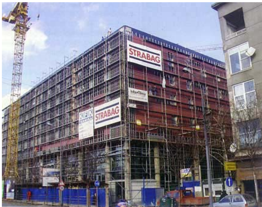
Pročelje zgrade u Branimirovoj ulici (siječanj 2003.)
