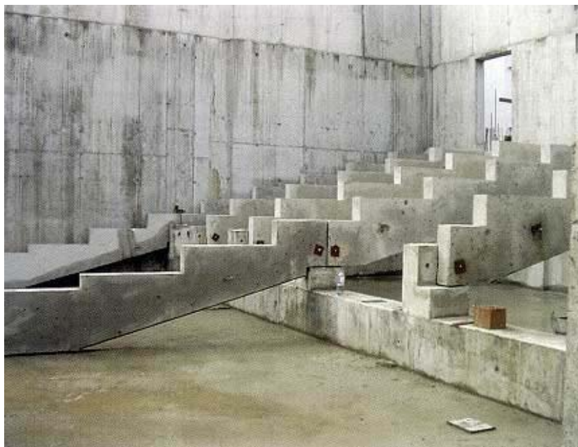
Montaža nosača gledališta u jednoj kino-dvorani (listopad 2002.)
