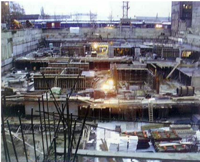
Radovi u podzemnom dijelu građevine (kraj 2001.)
