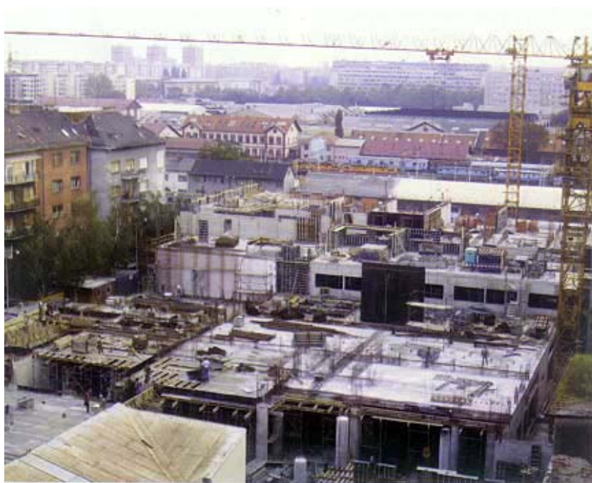
Gradilište u kolovozu 2002.
