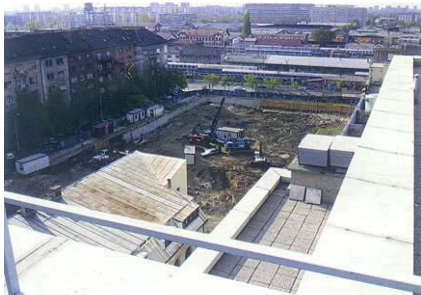
Pripreme za iskop građevne jame (travanj 2001.)
