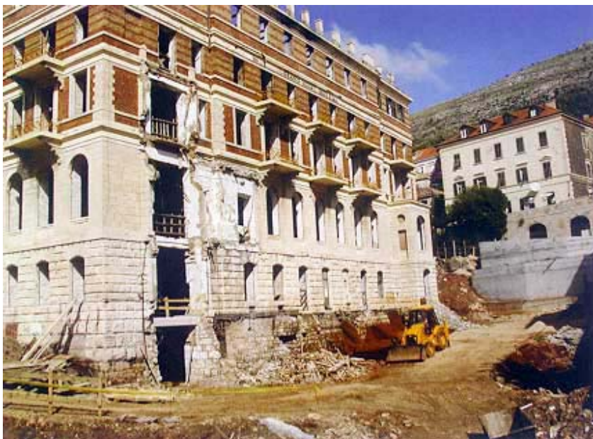
Pogled na gradilište uz istočno pročelje hotela
