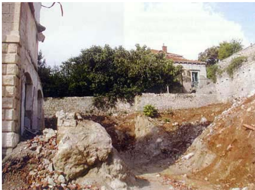
Iskopi uz sjeverni rub gradilišta
