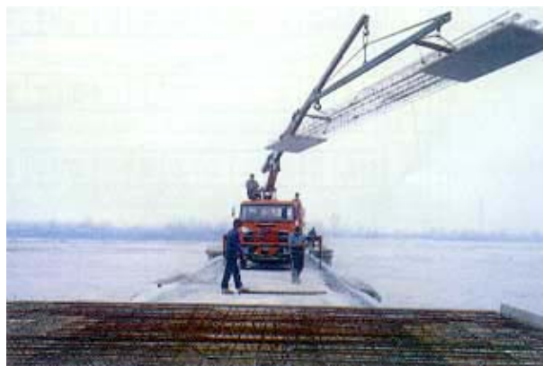
Slika 3. Montaža ploče autodizalicom
