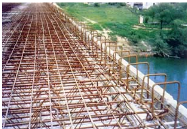
Slika 2. Ugrađena armatura u omnia ploču
