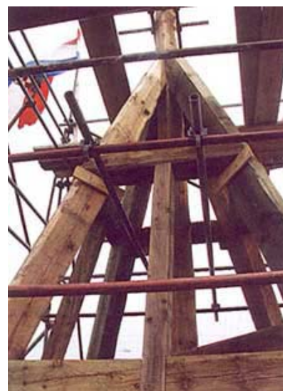
Detalj izvedbe krovne konstrukcije zvonika
