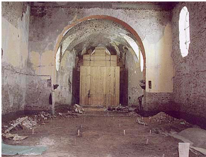
Unutrašnjost crkve u fazi obnove
