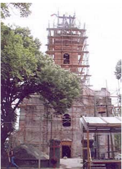
Faza obnove Sotinske crkve
