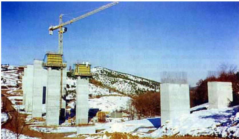
Gradilište vijadukta Miljanica
