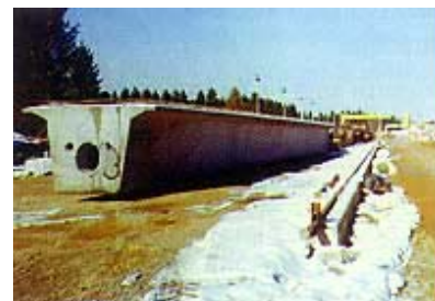
Izgrađeni U-nosač na mjestu proizvodnje
