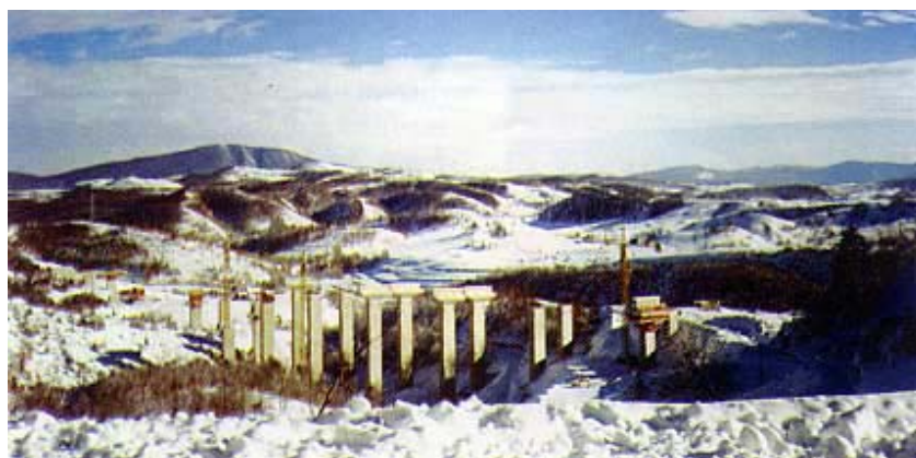
Vijadukt Moduš 1 u izgradnji
