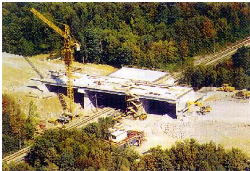
Gradilište nadvoznjaka preko željezničke pruge između Bosiljeva i Josipdola (kolovoz 2001.)
