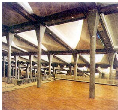
Pogled na konstrukciju iznutra
