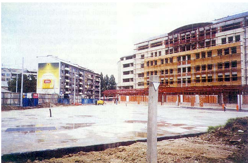
Pogled na gradilište (lipanj 2001.)
