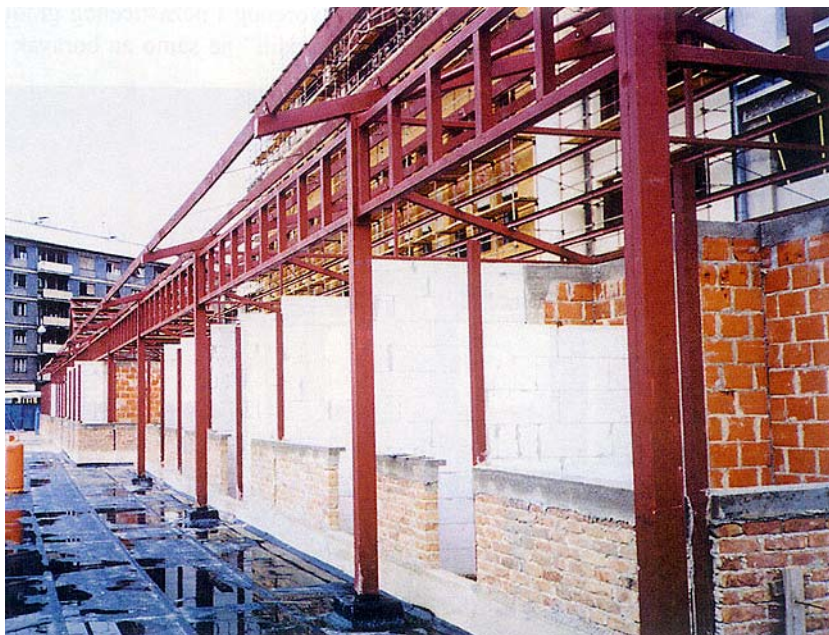
Kiosci u gradnji na otvorenom dijelu tržnice
