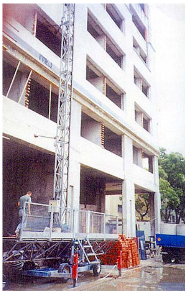
Detalj dvorišnog pročelja
