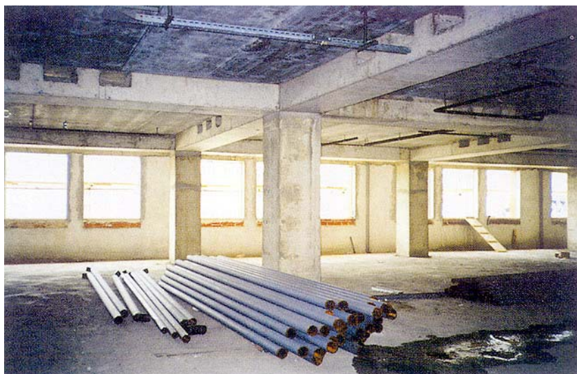
Radovi u unutrašnjosti građevine na višim katovima
