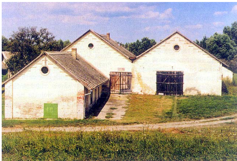
Crpna stanica Podunavlje prije obnove
