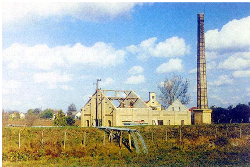
Crpna stanica Draž prije obnove
