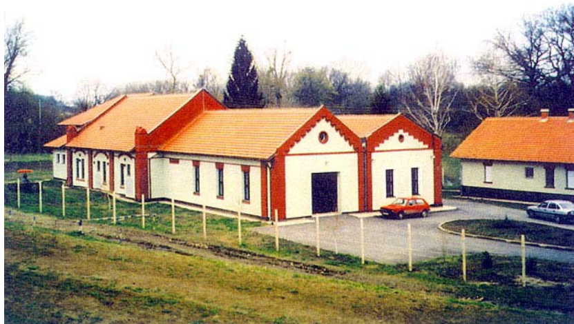
Crpna stanica Zlatna Greda nakon obnove
