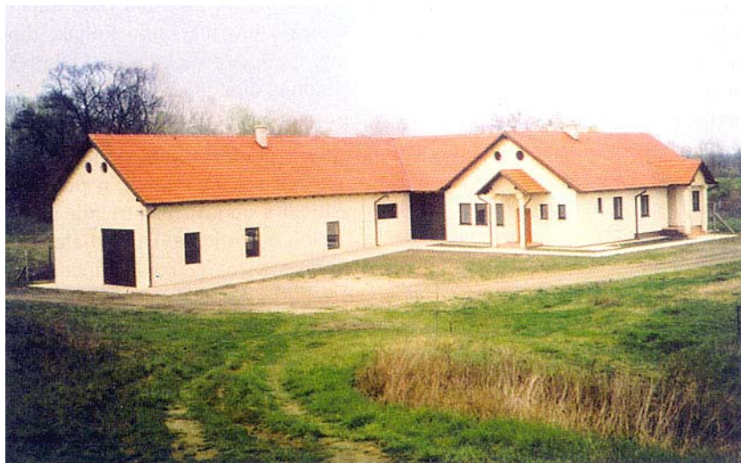
Crpna stanica Podunavlje nakon obnove
