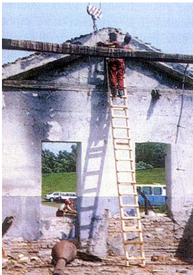
Dio crpne stanice Zlatna greda prije obnove
