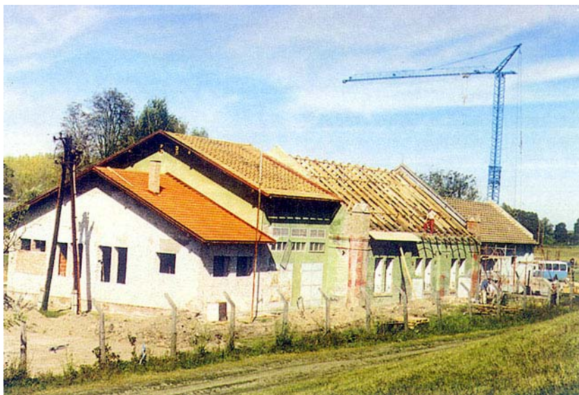
Crpna stanica Zlatna Greda prije obnove
