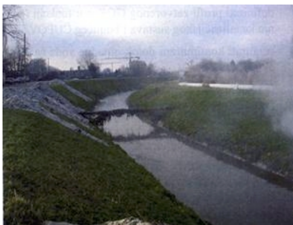
Slika 3. Glavni odvodni kanal danas
