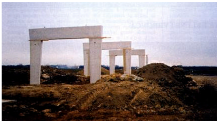
Stupovi za most Lonjica
