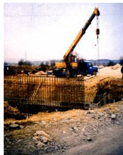
Radovi na putnom prijelazu Negovec
