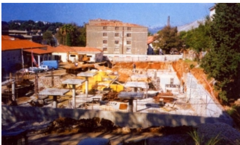
Armiranobetonski radovi u budućoj podzemnoj garaži
