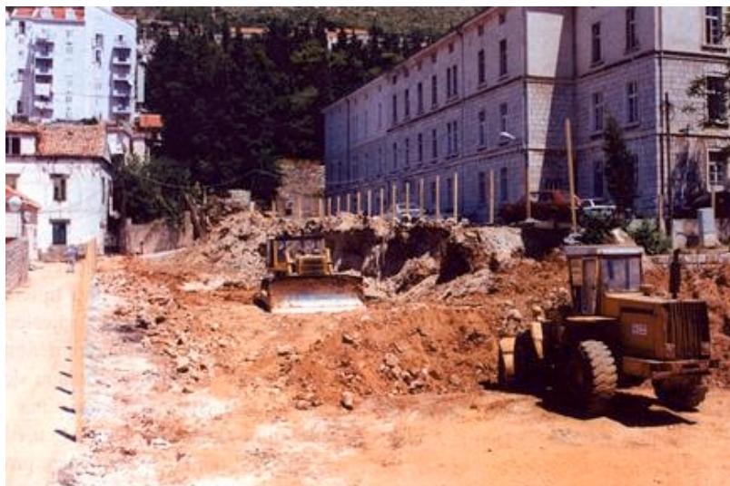
Početak iskopa građevne jame
