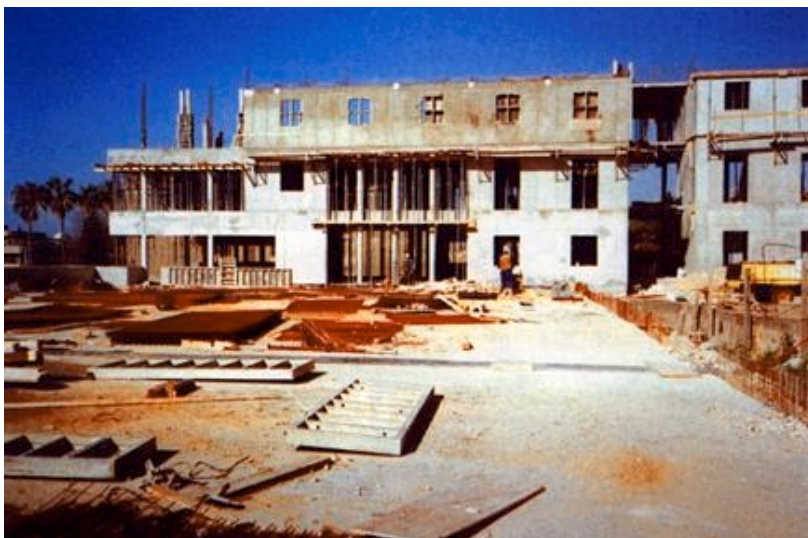
Armiranobetonska konstrukcija pri kraju izvedbe
