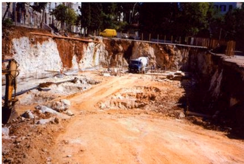
Početak temeljenja Objekta 3
