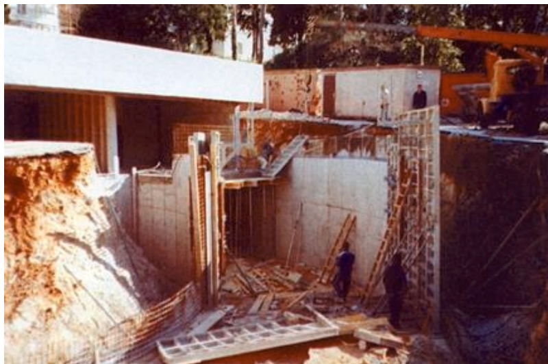
Ugradnja ulaznoizlazne rampe u podzemnu garažu
