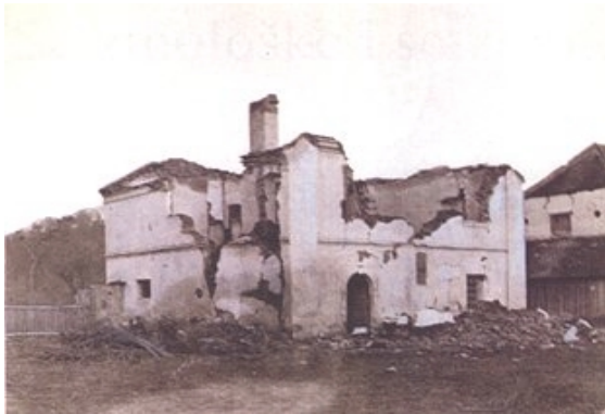
Slika 19. Srušena kuća u Kustošiji
