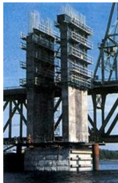
Stupovi u gradnji
