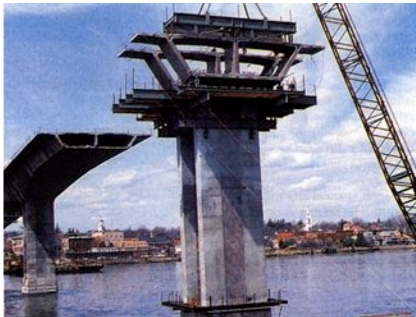
Ugradnja odsječaka nosača
