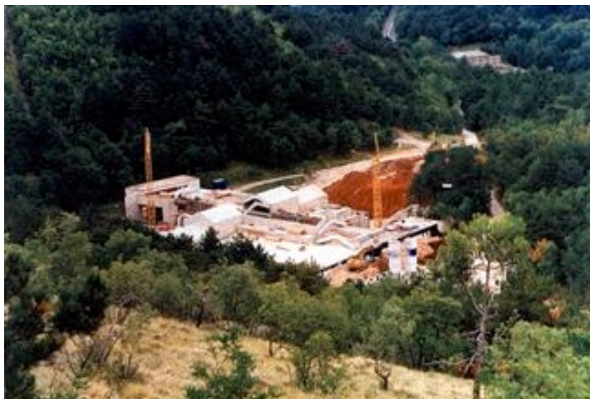
Pogled odozgo na gradilište
