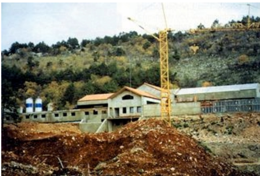
Vodopsrema Streljana 2 pred završetkom radova
