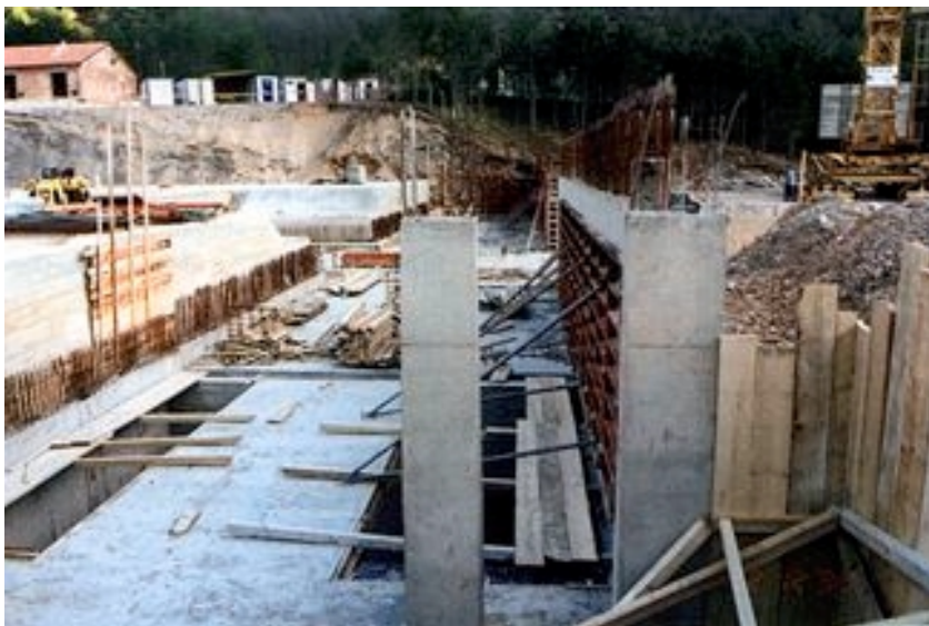
Radovi na temeljnoj ploči
