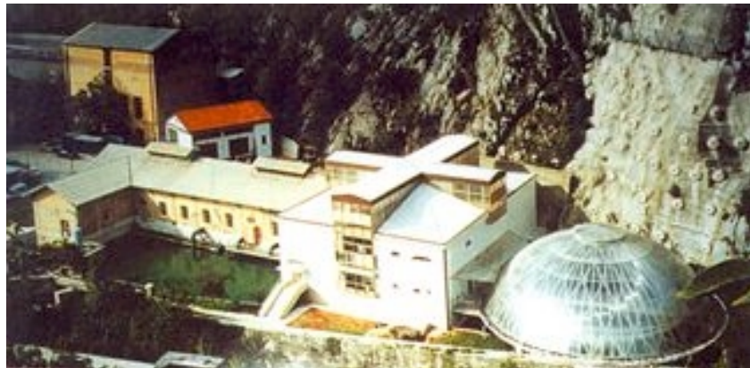
Nova crpna stanica Zvir 1
