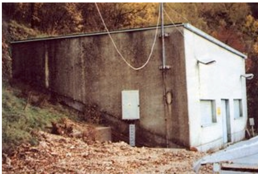
Zgrada stare vodospreme
