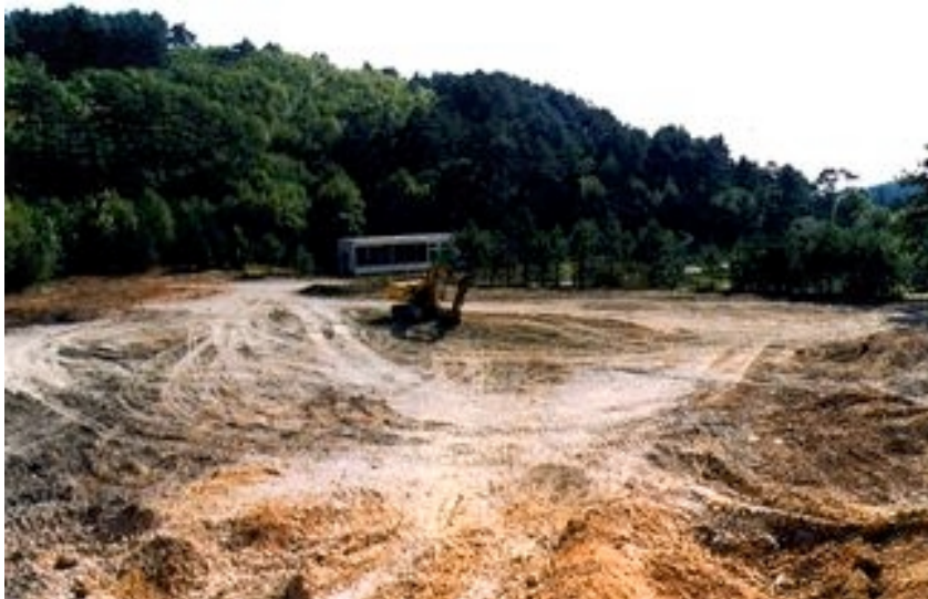
Početak radova na gradilištu vodospreme
