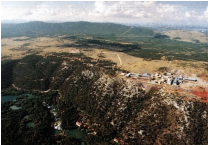
Snimak iz zraka vodocrpilišta te uređaja za kondicioniranje vode s vodospremom
