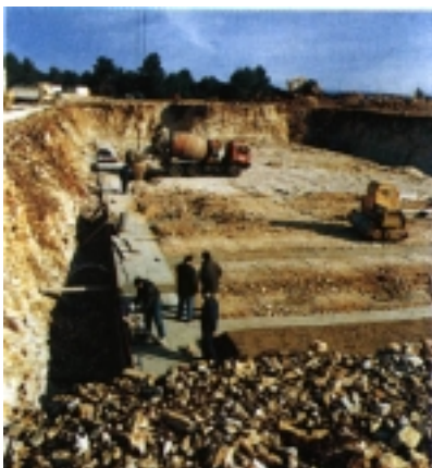
Radovi u građevnoj jami
