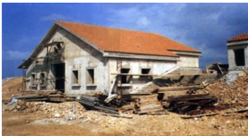
Radovi na ulazno-izlaznoj građevini u vodospremu
