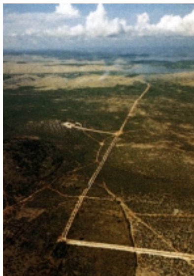
Tragovi iskopa za trasu vodovoda u kameniaru
