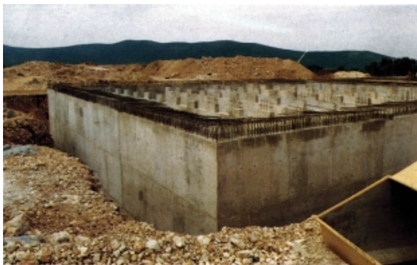
Završni radovi betoniranja vodospreme
