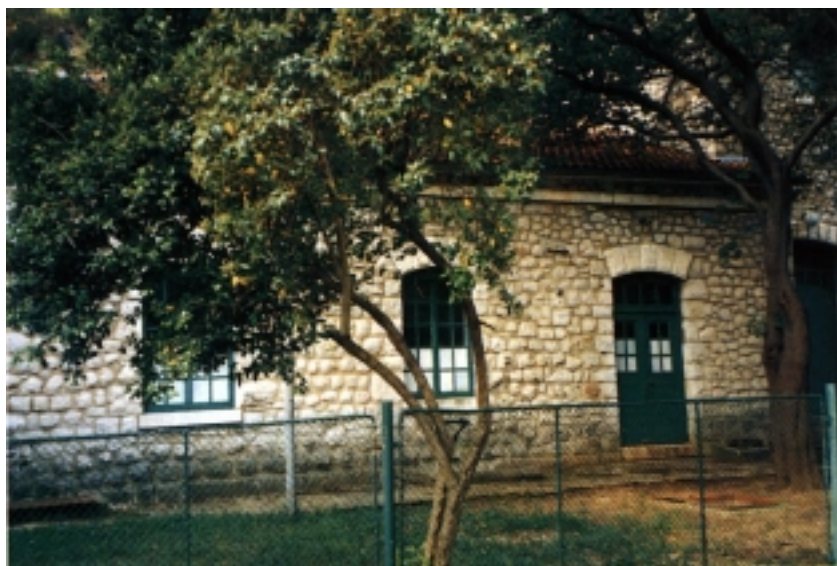
Dio stare zgrade vodocrpilišta Jaruga
