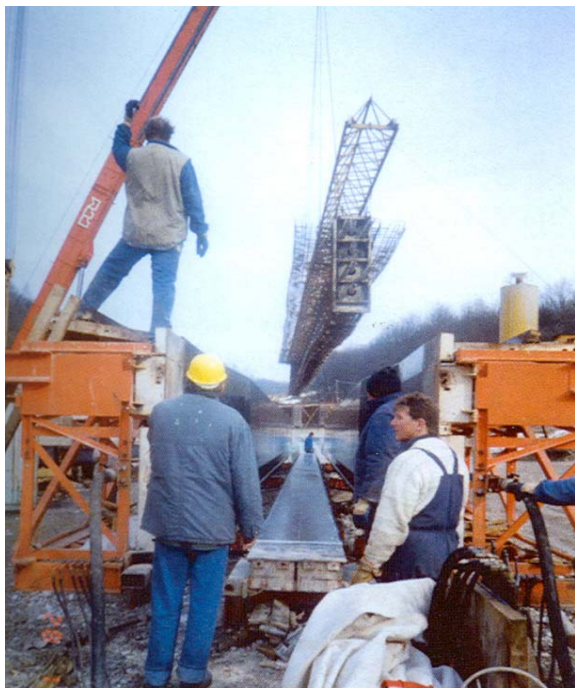
Slika 3. Odlaganje armaturnog koša, kablova i čela nosača u kalup "Hünnebeck"
