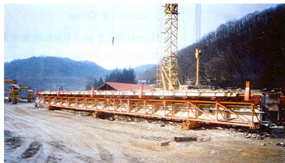
Slika 2 Dizanje armaturnog koša, kablova i čela nosača (vijadukt "Visočki Kraj")
