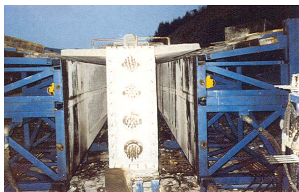
Slika 6. Izbetonirani nosač (vijadukt "JABLAN II")
