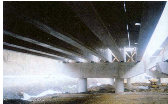
Slika 10. Nosači na naglavnici vijadukta
