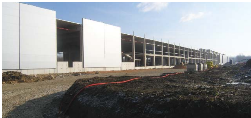
Gradilište hale tijekom posjeta (pogled sa sjeverozapada)
