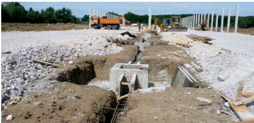
Početni radovi na gradilištu (temeljenje stupova)
