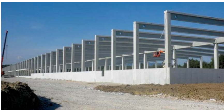
Montirani stupovi i gredni nosači
