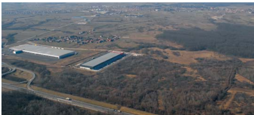
Prostor gospodarske zone prije gradnje logističko-distribucijskog centra (vide se skladišta Magme i Lidla)
